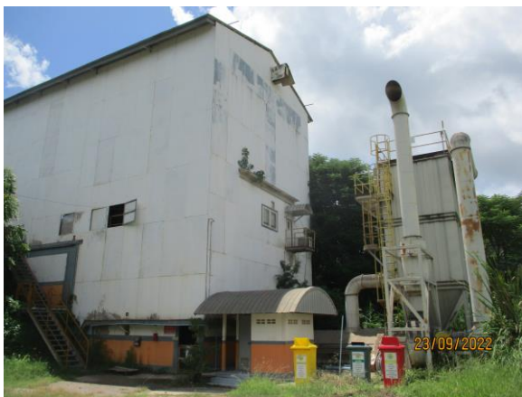
รูปที่ 8 ผนังปิดคลุมมิตชิดโรงโม่หิน
